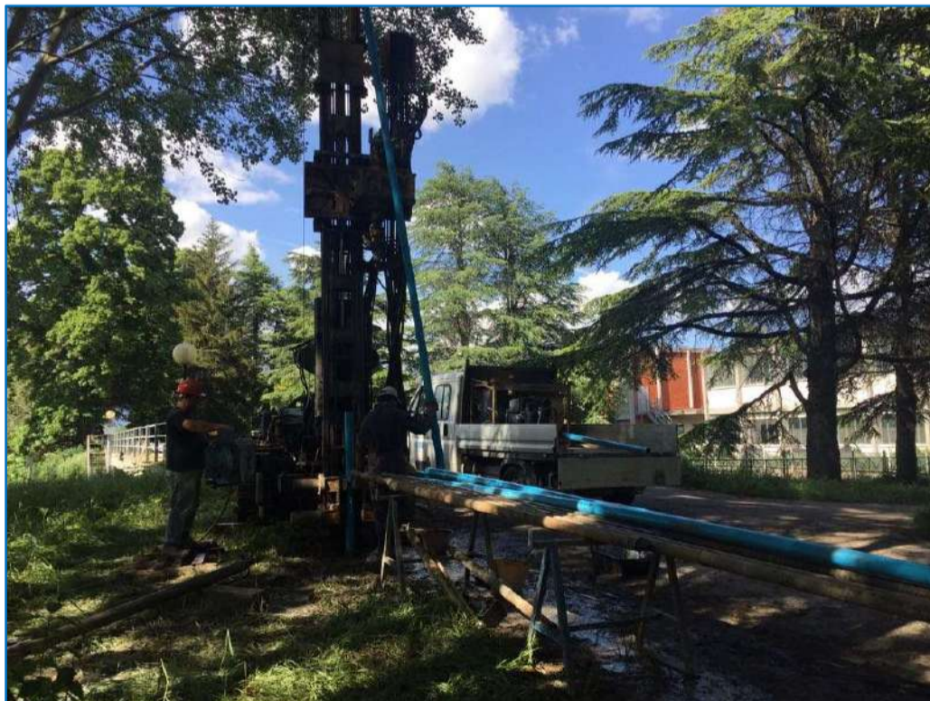
ALLESTIMENTO TUBO CIECO PER DOWN-HOLE
